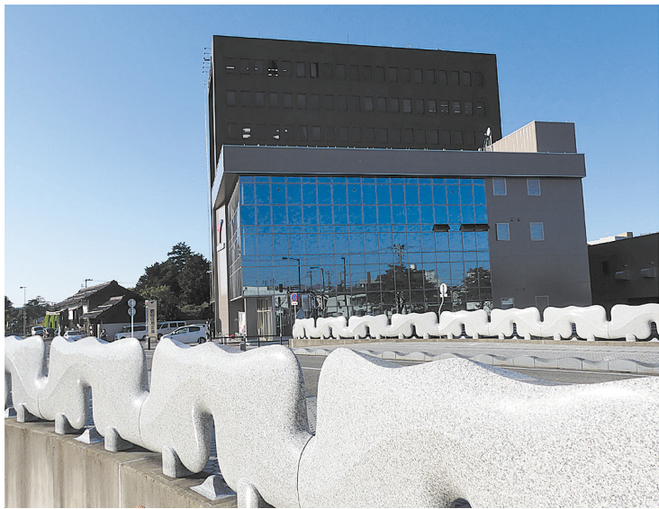
「空にかけける階段」千歳橋は平成13(2001)年12月に完成。バックの建物は鶴岡信用金庫本店
